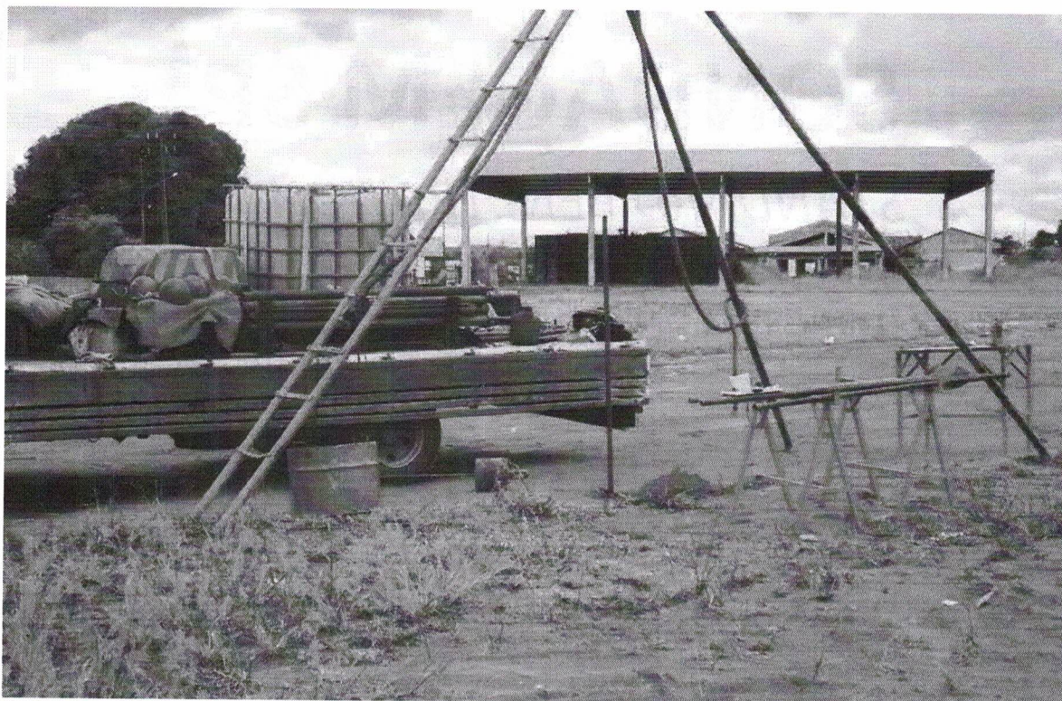
EXECUÇÃO DE SONDAGENS NO LOCAL
